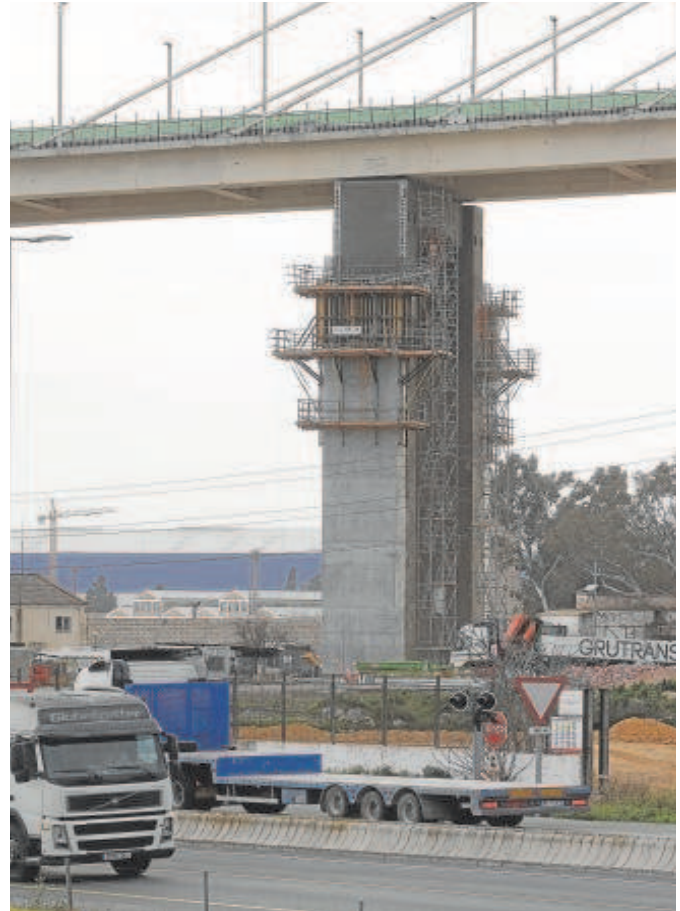
Camiones circulando bajo el puente // MANUEL GÓMEZ
