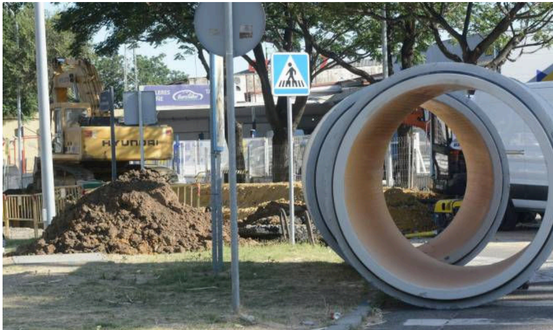
Obras de Emasesa en una imagen de archivo. / El Correo
