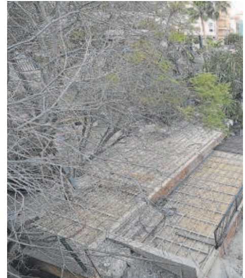
Obras en la terraza de Puerto de Cuba que están paralizadas
