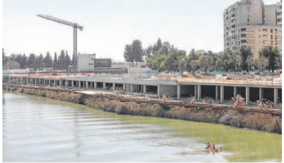
Obras en el Jardín de las Cigarreras donde se creará un parking subterráneo // RAÚL DOBLADO
