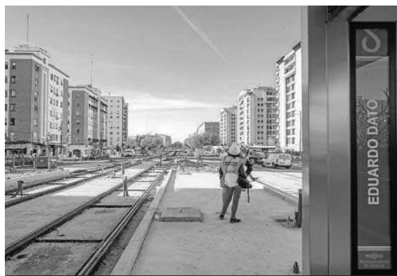
Primeras paradas instaladas en Eduardo Dato.
