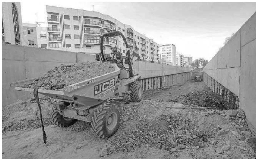
Un operario trabaja en el paso inferior de Ramón y Cajal con San Francisco Javier.
