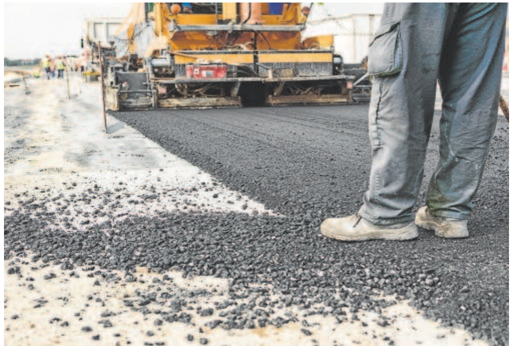
Operarios durante los trabajos de asfaltado de una carretera // ABC
