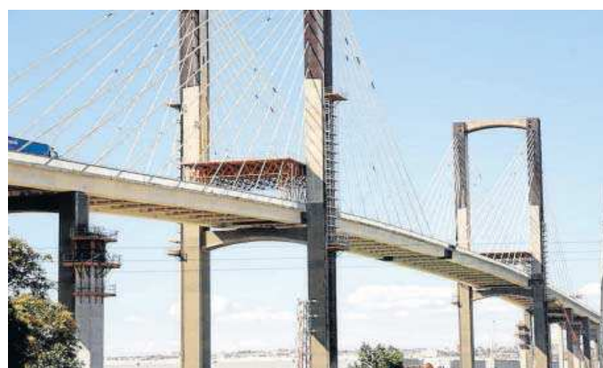
El refuerzo de las pilas de retenida se ha ejecutado al 95%.
