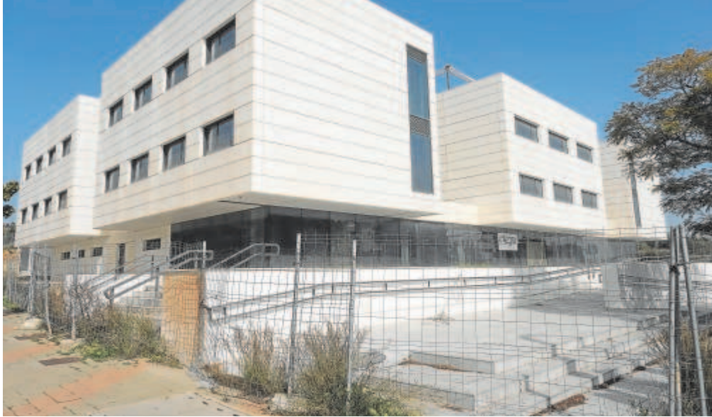
Edificio del centro de Málaga, casi terminado por fuera pero inconcluso en su interior // FRANCIS SILVA
