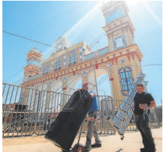
Trabajos de montaje de la Feria 2023 // MAYA BALANYA
