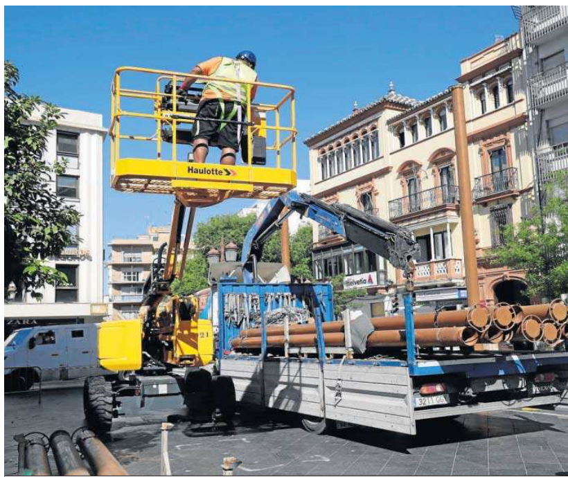
Llegada de las estructuras de las velas de la Campana.
