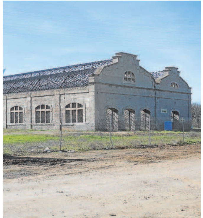
Espacio en el que se instalará la incubadora de empresas// VANESSA GÓMEZ
