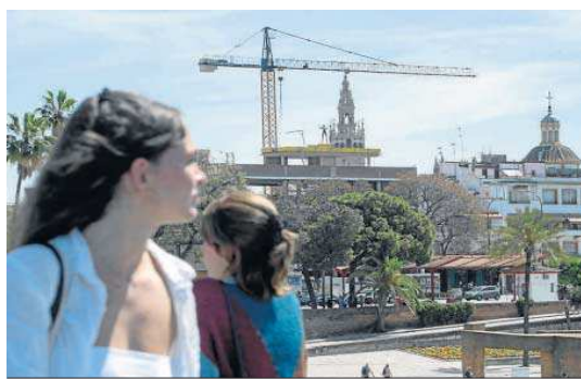
La obra del edificio que oculta la Giralda desde el Puente de Triana.
