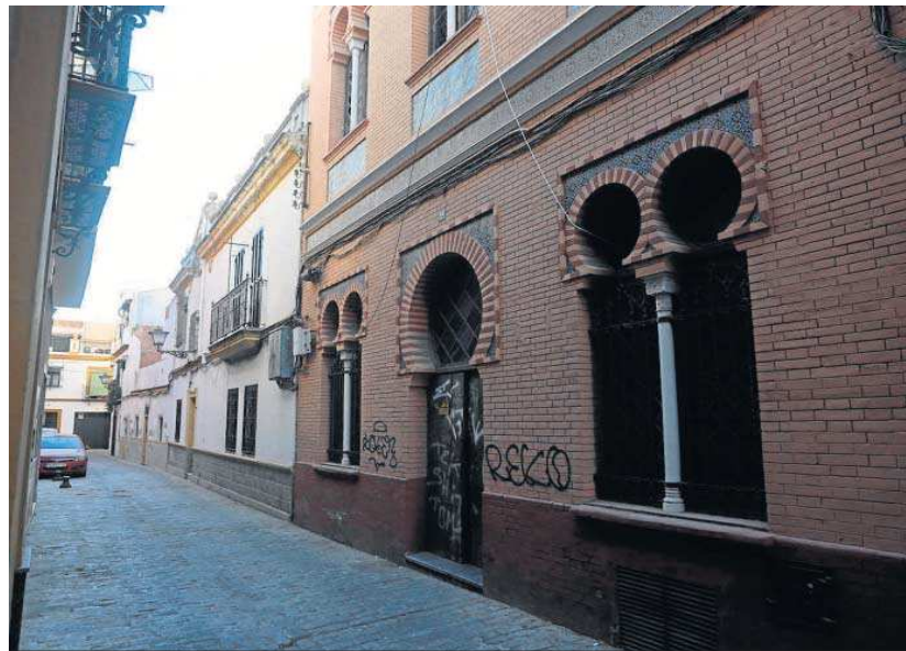
El centro de transformación de la calle Arte de la seda.
