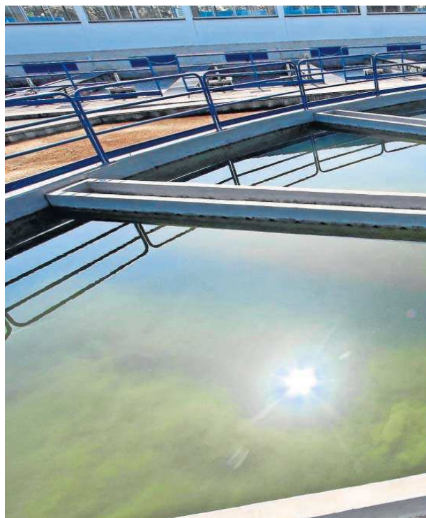
Planta de El Carambolo donde se colocarán membranas para tratar el agua.
