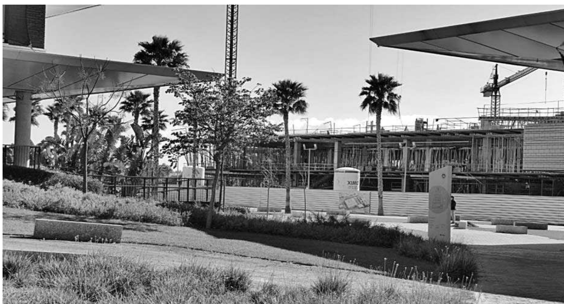
La Facultad de Ciencias de la Salud que se construye en el campus de la Loyola.
