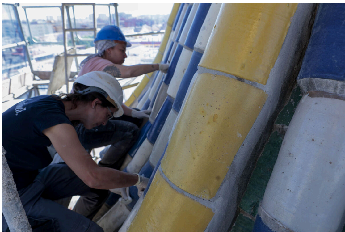
Trabajos en las tejas. / Juan Carlos Muñoz
