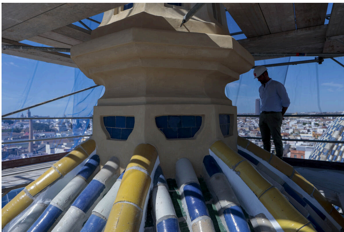
Una de las torres con el revestimiento recuperado. / Juan Carlos Muñoz
