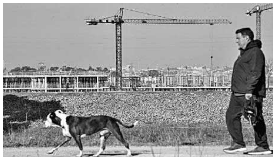
Un vecino pasea a su perro cerca de las obras de Palmas Altas.
