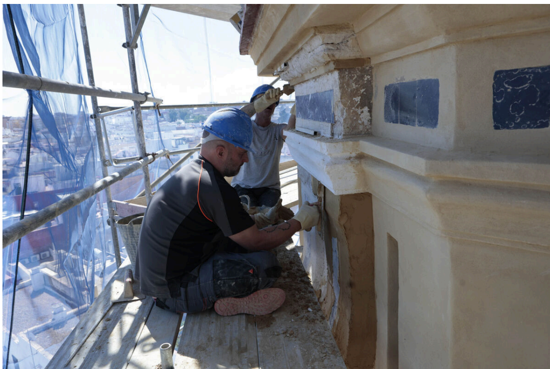
Trabajos de restauración en la torre sur. / Juan Carlos Muñoz
