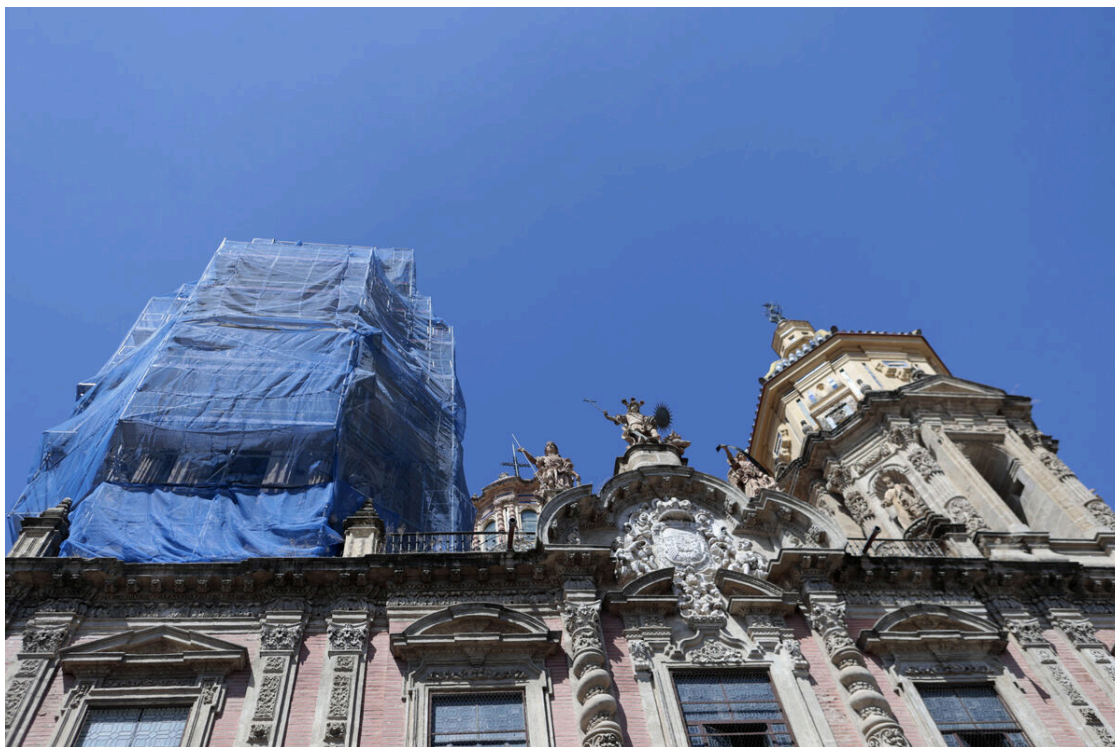
La torre sur cubierta de andamios. / Juan Carlos Muñoz
