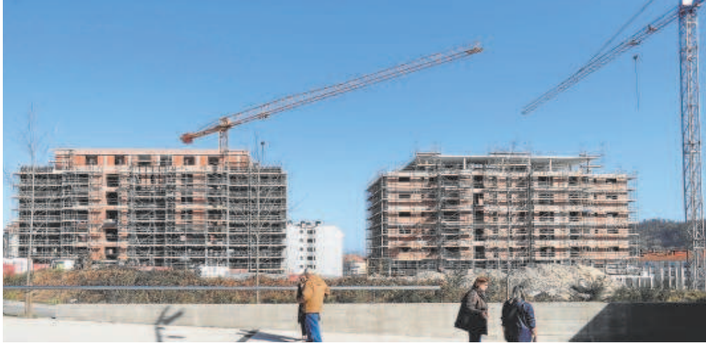
Un edificio de viviendas en construcción en La Coruña // MIGUEL MUÑOZ
