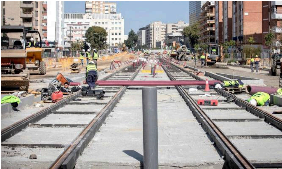
Albañiles durante las obras de ampliación del tranvía de Sevilla en la Avda. de San Francisco Javier. / María José López - E.P.
