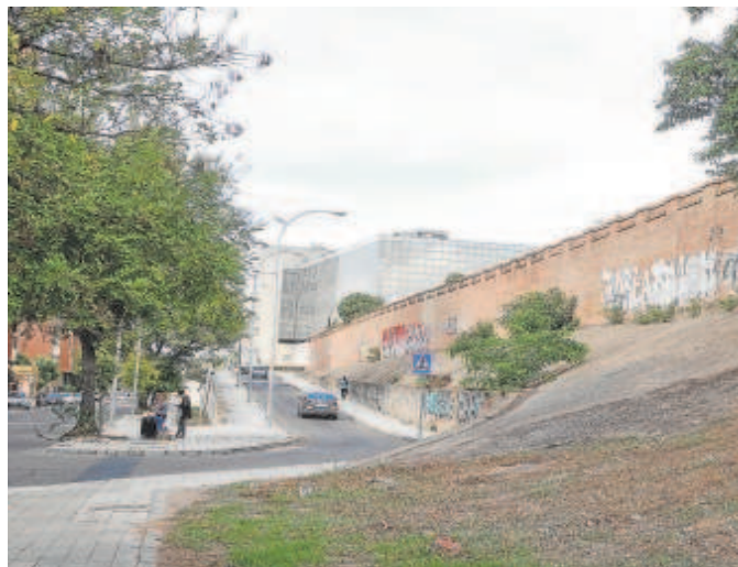
El proyecto anuncia el derribo del muro que aísla al Polígono Sur // MANUEL GÓMEZ
