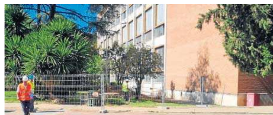
Primeros trabajos en el interior de la antigua fábrica de Altadis.
