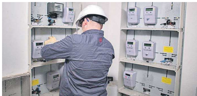
Otras de las revisiones en el cuadro de contadores de un bloque de pisos en Las Tres Mil Viviendas.
