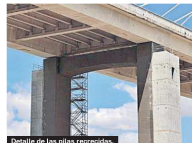
Detalle de las pilas recrecidas.
