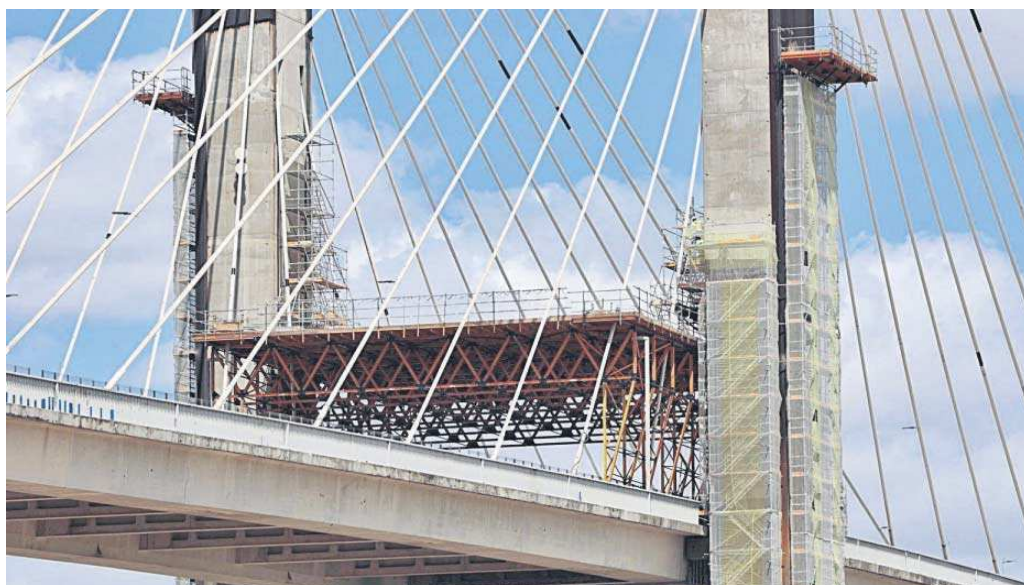
Trabajos para recrear los pilonos centrales del puente del Centenario, esta semana.
