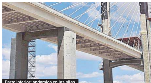
Parte inferior: andamios en las pilas.
