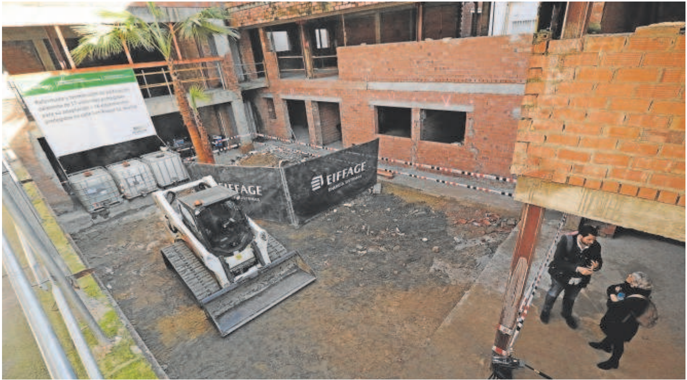
Obras de construcción de una de las promociones de viviendas públicas de alquiler para jóvenes impulsadas por la Junta // JUAN FLORES
