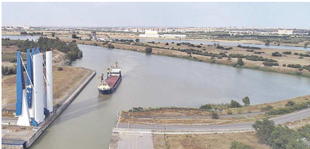
Uno de los puentes móviles de la esclusa de Sevilla.
