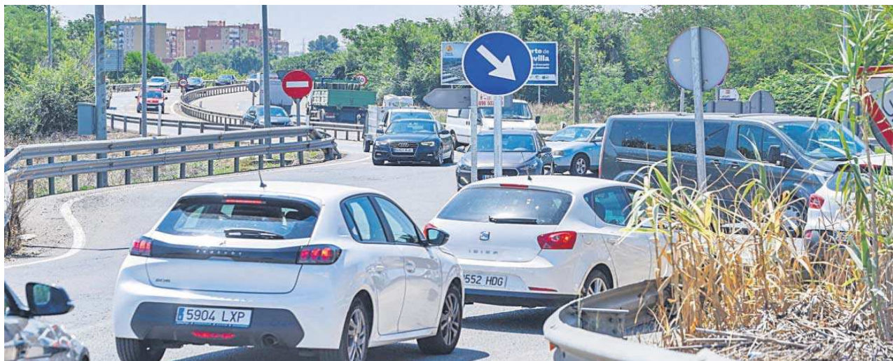
La ronda Supernorte (SE-20) en el punto donde confluirá con la línea 3 del Metro.
