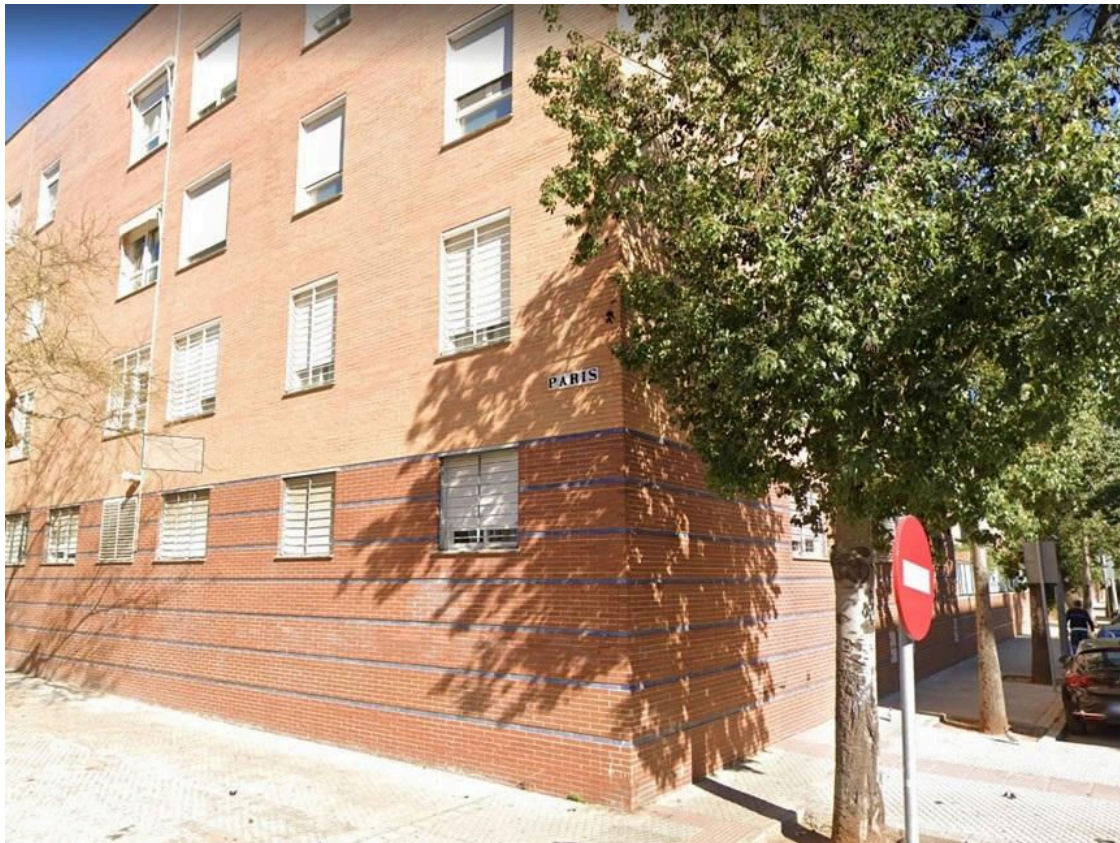
Bloque de viviendas públicas en Sevilla. - JUNTA DE ANDALUCIA
