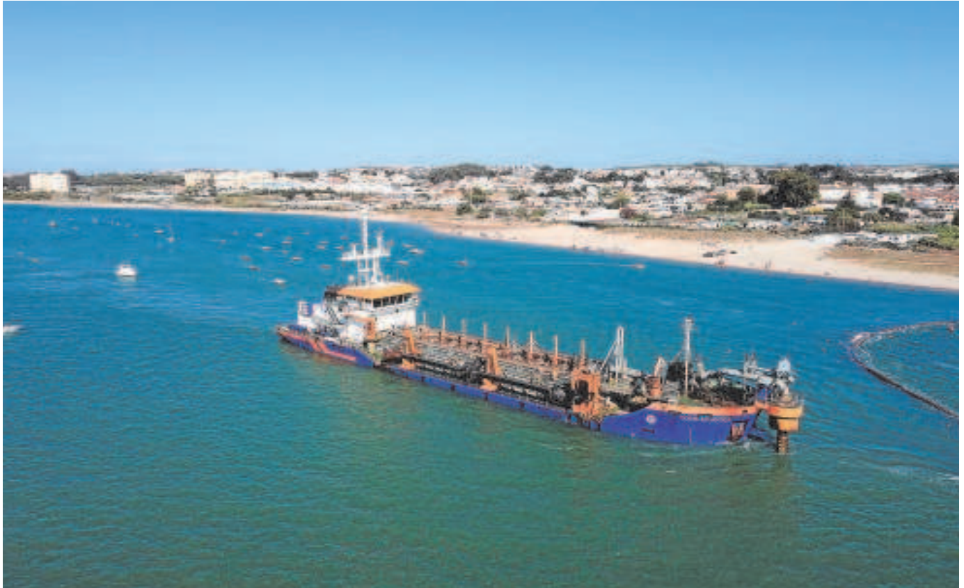
Un barco llevando a cabo el dragado de mantenimiento del río Guadalquivir // ABC
