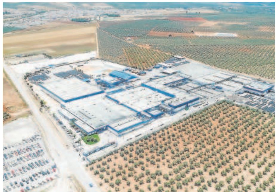
Instalaciones de la cooperativa Agrosevilla en La Roda // NAVARRO
