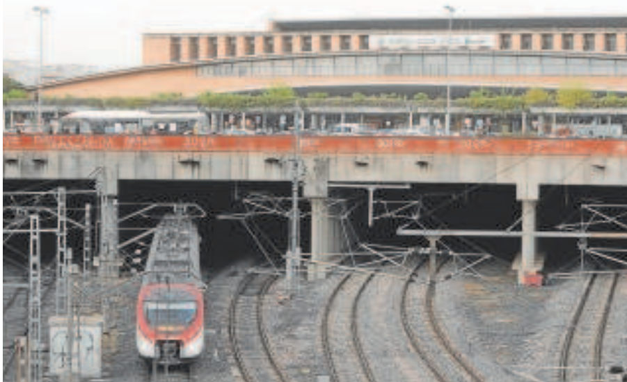
El proyecto soterra vías y reurbaniza el entorno de la estación // RAÚL DOBLADO
