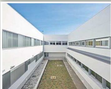
Huelva Obra finalizada del nuevo centro de Educación Infantil y Primaria de tres líneas en Huelva, que ha contado con un presupuesto de 6.419.632 euros.
