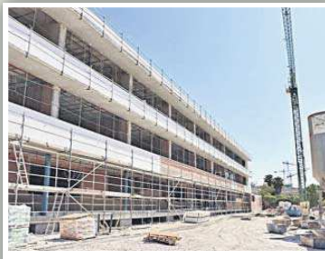
Marbella (Málaga) Construcción del nuevo instituto en la zona Hospital Las Chapas en Marbella que ha contado con una inversión de 6.207.739 euros.
