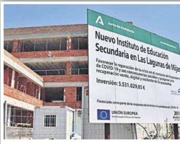
Mijas (Málaga) Obras del edificio que albergará el nuevo centro de Educación Secundaria Obligatoria de seis líneas en Mijas, con una inversión de 5,7 millones.
