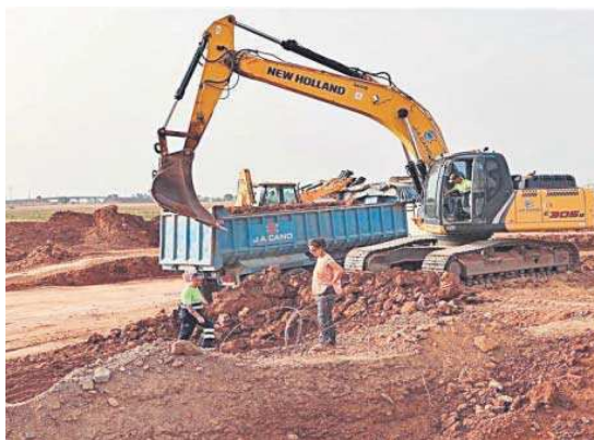
Obras en el ramal técnico de la Línea 3 del Metro.
