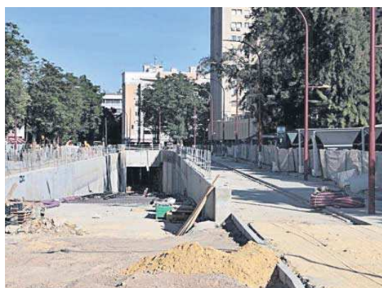
El túnel del tranvía. A la derecha, el carril del tráfico normal sin asfaltar.
