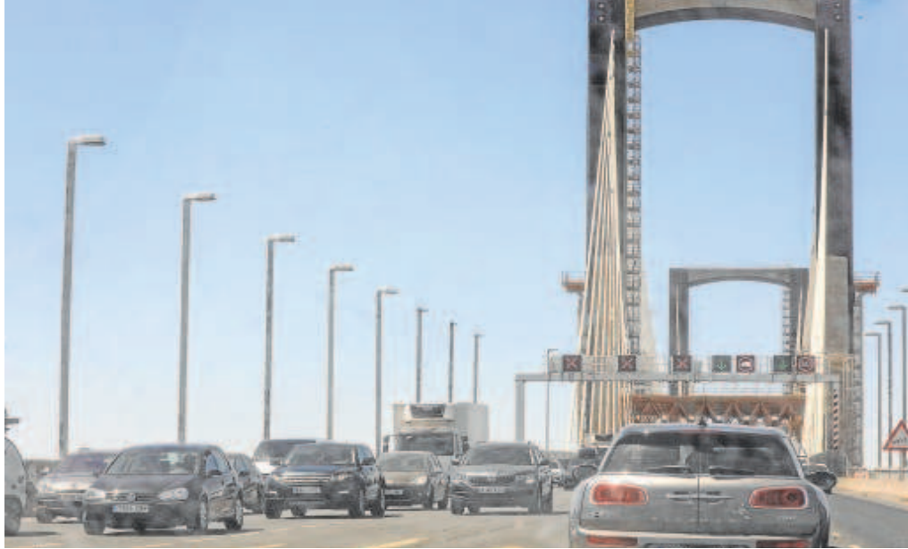
Tráfico pesado en el puente del Centenario donde están ya instalados los andamios de la obra // RAÚL DOBLADO
