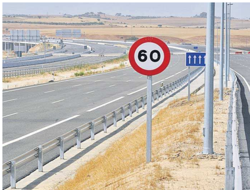
Un tramo de la SE-40 ya abierto al tráfico.
