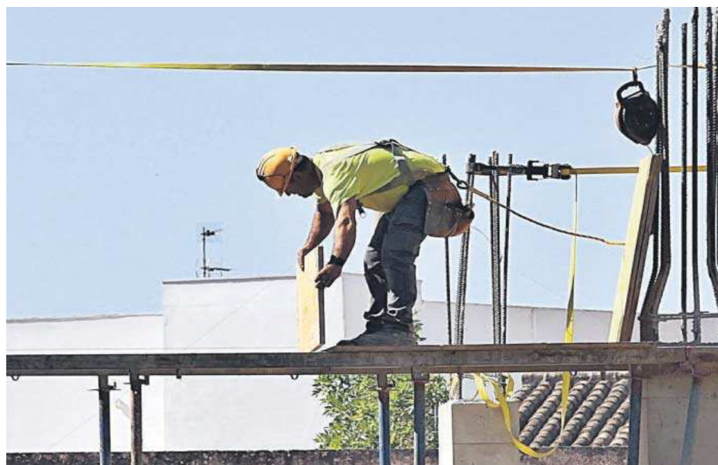
Un trabajador en una obra.
