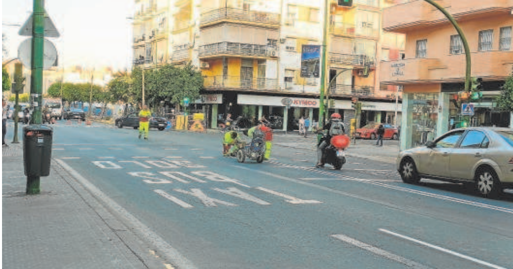
Operarios pintan, ayer, las señales del pavimento de la Carretera de Carmona // ABC
