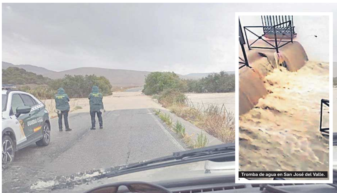
Uno de los cortes de carretera provocados por las fuertes lluvias en Paterna.
