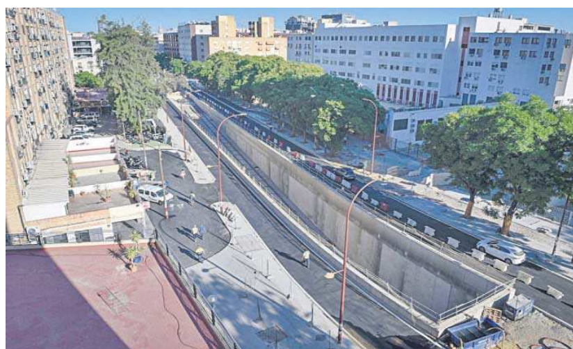
Vista del túnel por el que circulará el tranvía por Ramón y Cajal.
