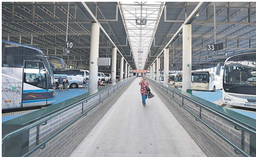
La nueva rampa de acceso a los andenes se adapta a la normativa y ha doblado su longitud.
