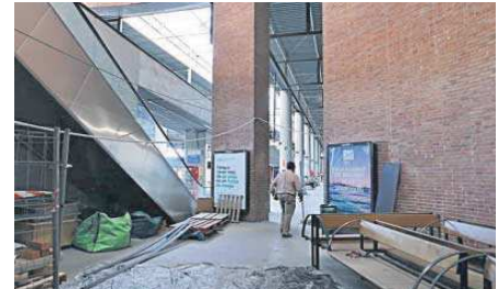
Material de obra junto a los nuevos aseos.
