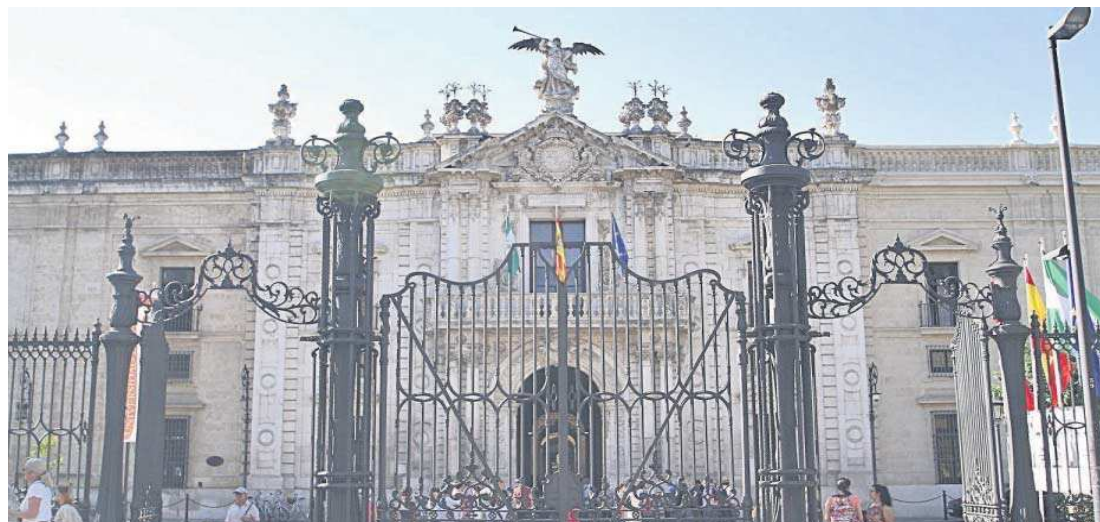
Entrada principal del Rectorado en la Calle San Fernando.
