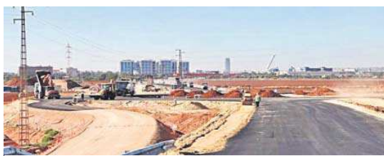
Obras del ramal técnico del tramo Norte de la línea 3 del Metro.
