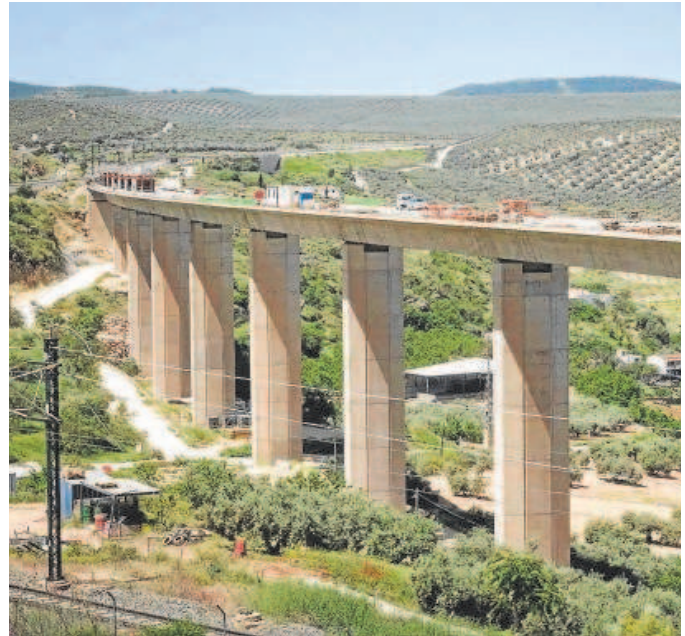
Tramo ya ejecutado del viaducto de Riofrío // IDEAL
