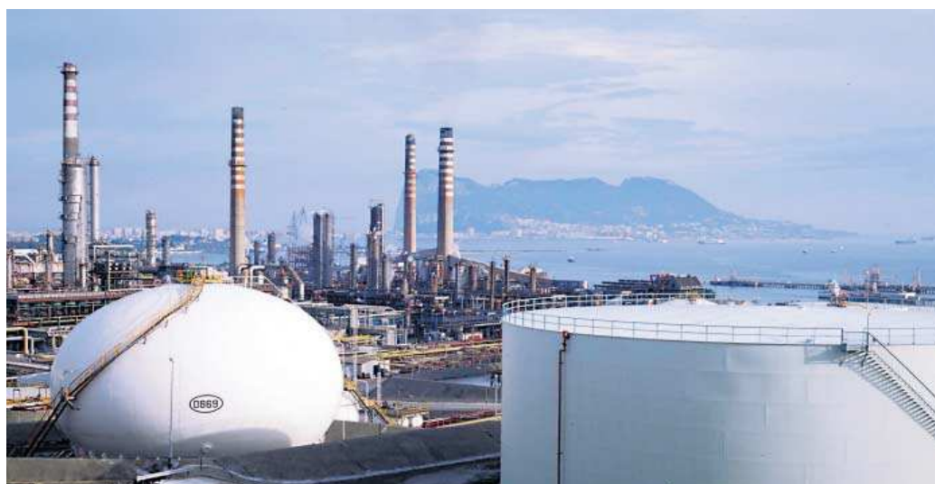
Instalaciones de la refinería San Roque-Gibraltar, la bajada de precios de los combustibles influyó en el comercio exterior.
