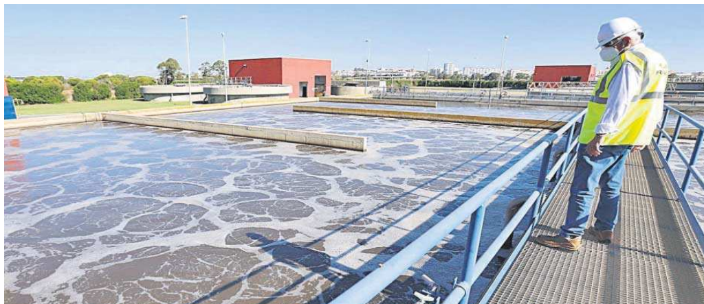
Estación depuradora de aguas residuales de Huelva.
