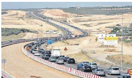
Obras de la SE-40 en 2010. JUAN CARLOS MUÑOZ
