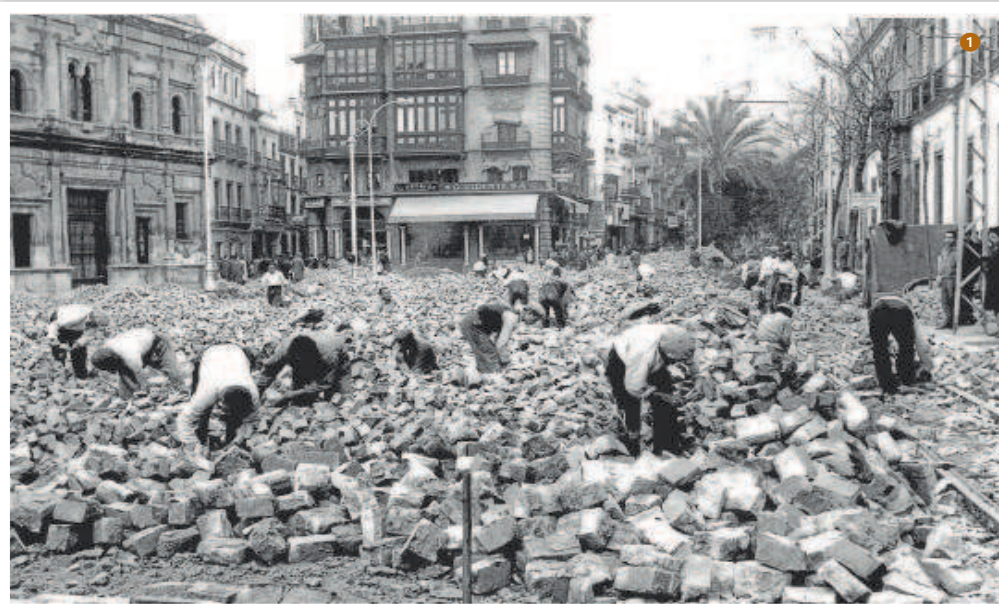
1 Operarios colocando uno a uno los adoquines de la plaza de San Francisco 2 La plaza en el siglo XIX, con el antiguo pavimento de chinos lavados 3 Adoquinando la calle Tetuán, en el Centro
