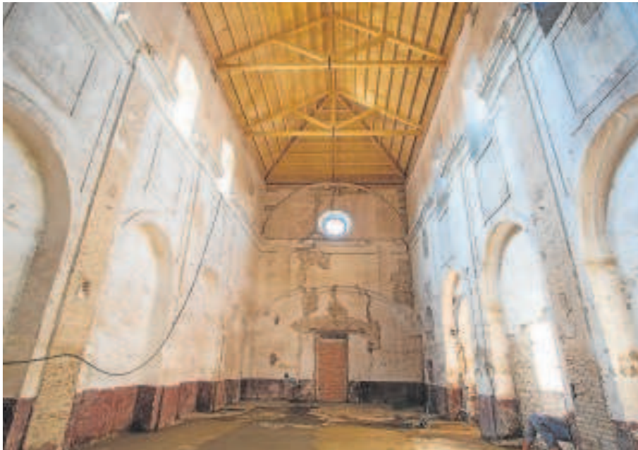
En 2020 se acometieron obras sobre la cubierta de San Laureano // ABC
