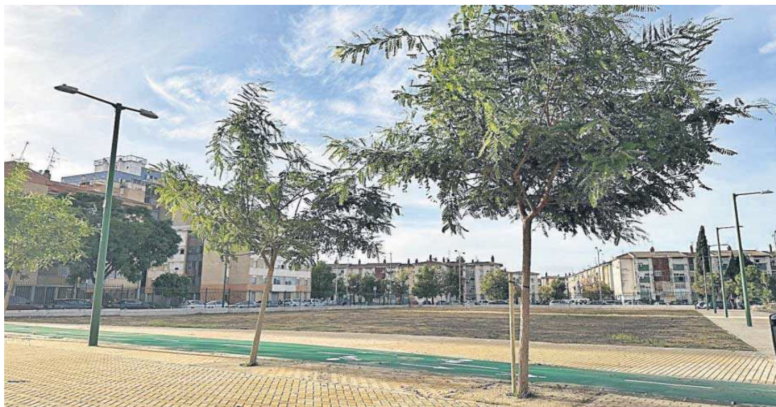
Estado de la parcela conocida como Vacío Central tras finalizar las obras de urbanización.
