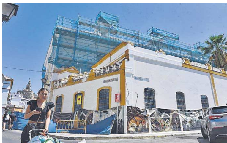
Las obras que se están desarrollando en las Reales Atarazanas.
