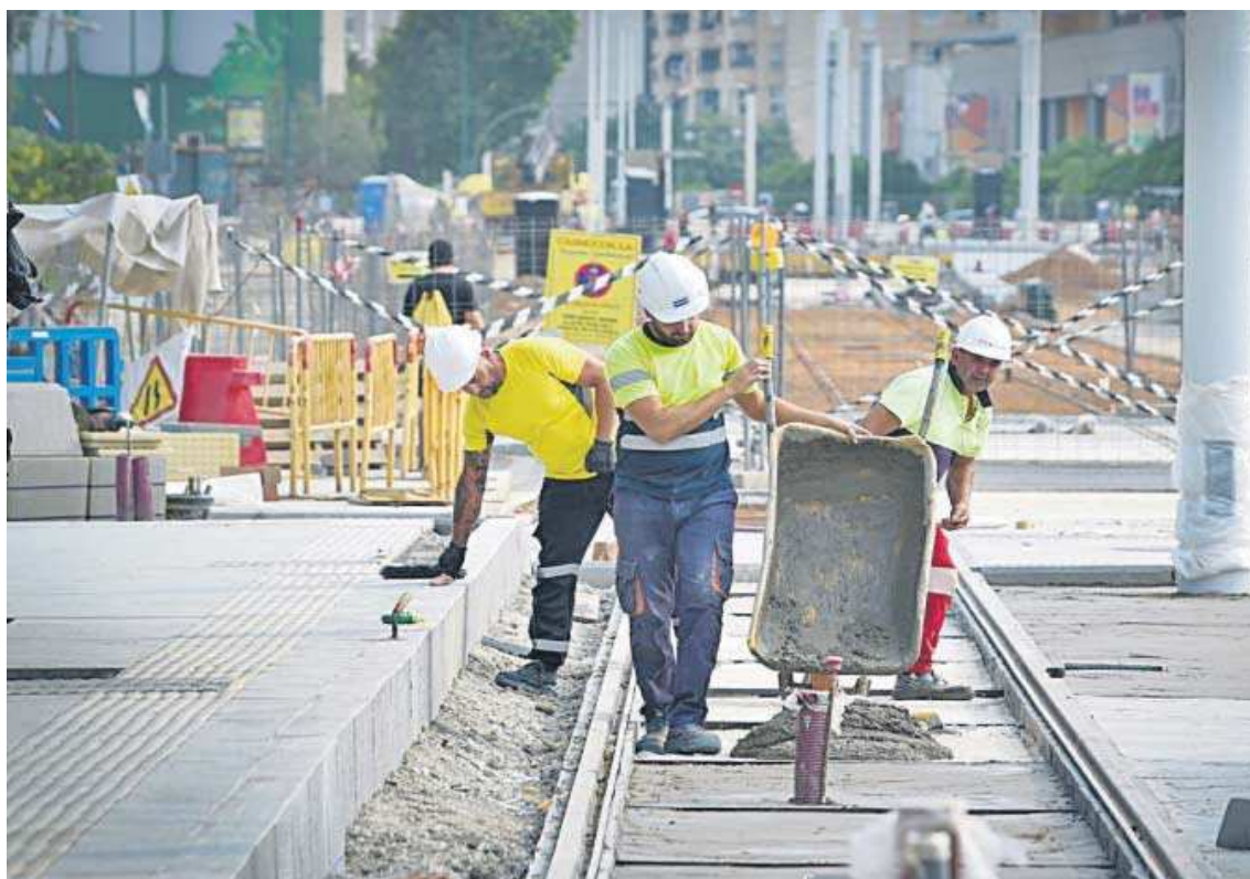
Operarios trabajan en la ampliación del tranvía este verano.
