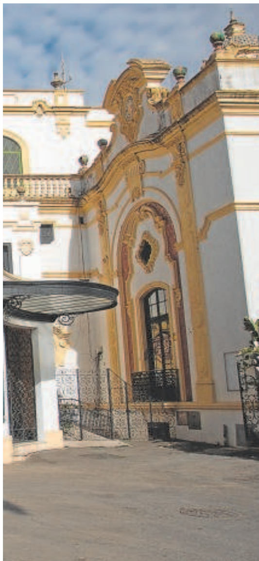
rehabilitación del edificio // VANESSA GÓMEZ
