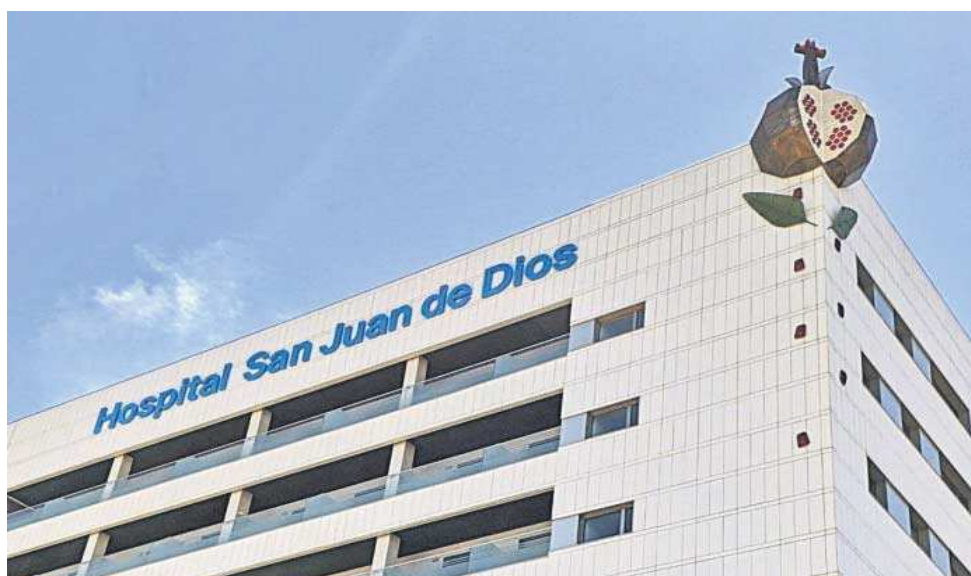
Edificio del nuevo hospital de San Juan de Dios.
