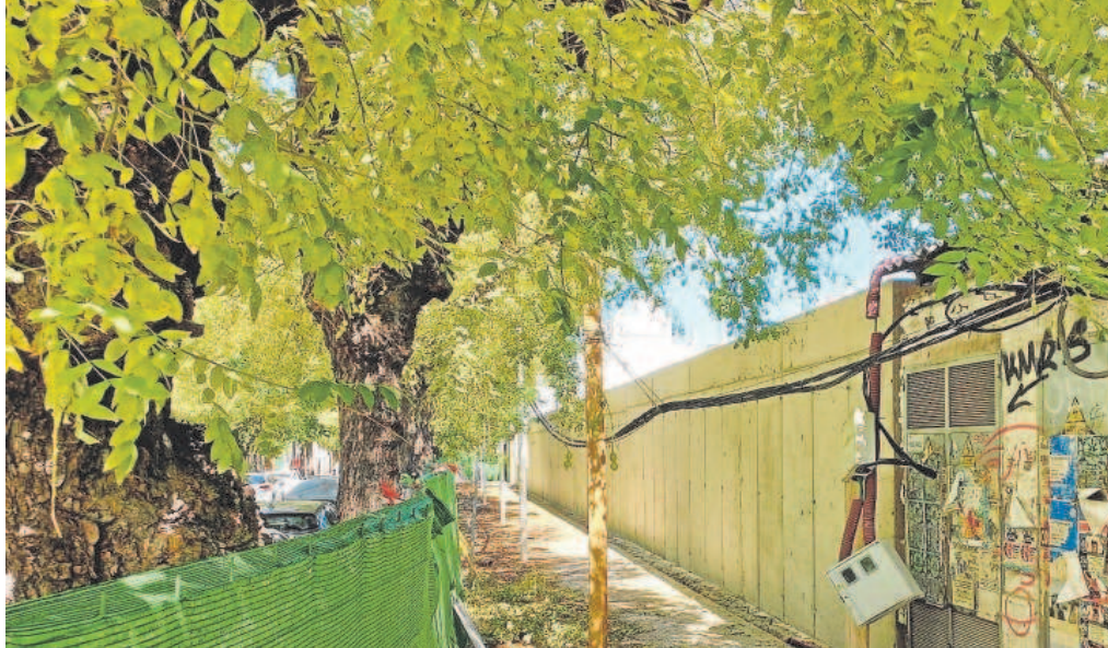
Imagen del «nuevo muro» de la avenida de Miraflores // ABC
