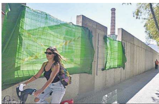
Aspecto actual del muro en la avenida Miraflores de la Macarena. JUAN CARLOS VÁZQUEZ
