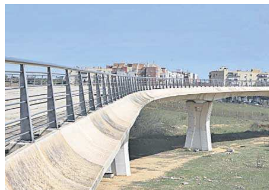
Estructura del tranvía en Alcalá.
