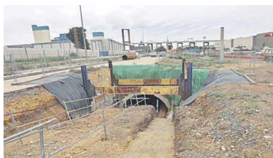
Vista de la obra de ampliación y mejora del colector.
