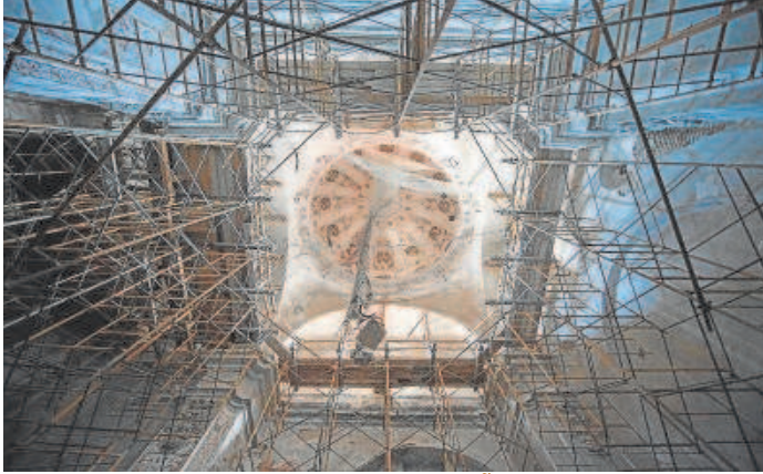
EL CONSERVATORIO DE LA CALLE BAÑOS La antigua iglesia del convento del Carmen está abandonada // FOTOS: RAÚL DOBLADO
