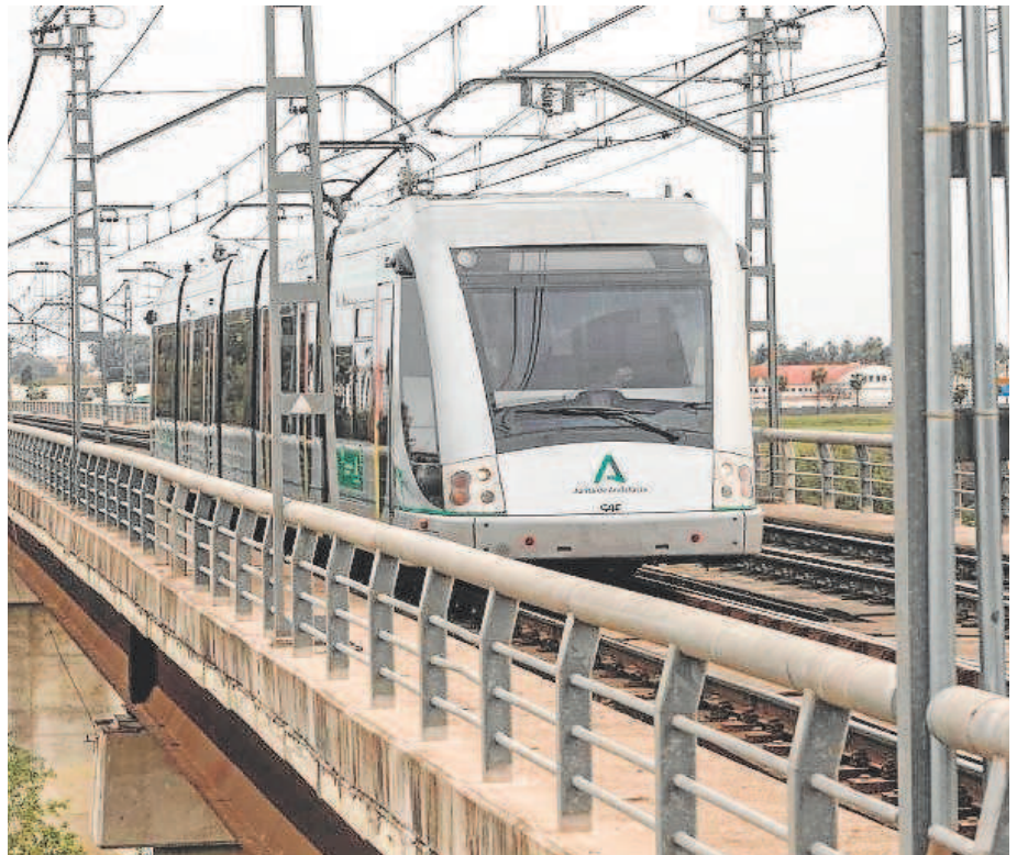
Un vagón de la línea 1 del metro de Sevilla // ABC
