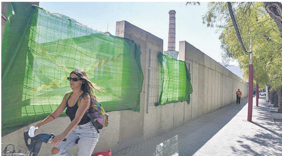
Estado actual del muro de 4 metros alrededor de la Fábrica de Vidrio.
