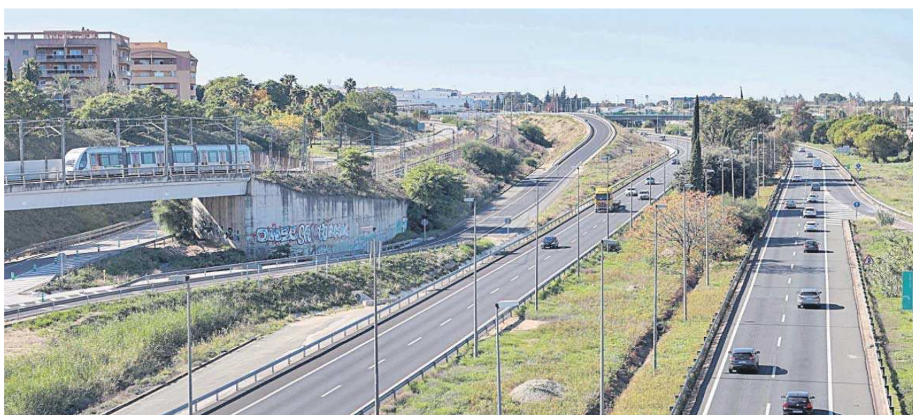
Por la mediana de la autovía de Mairena (A-8057), en la imagen, discurrirá el carril Bus-VAO del Aljarafe central.
