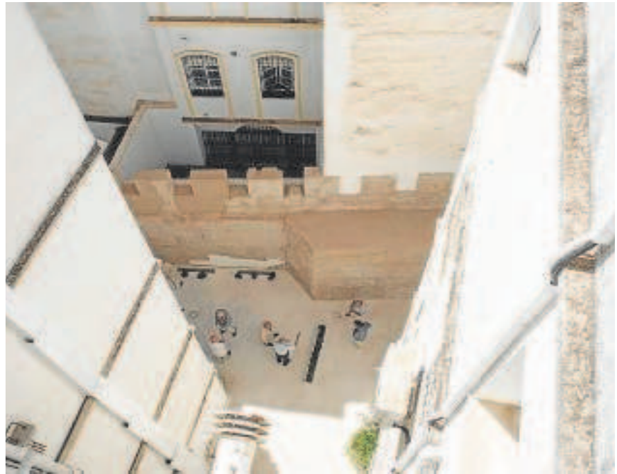
La muralla de la calle Castelar tras su rehabilitación // ABC
