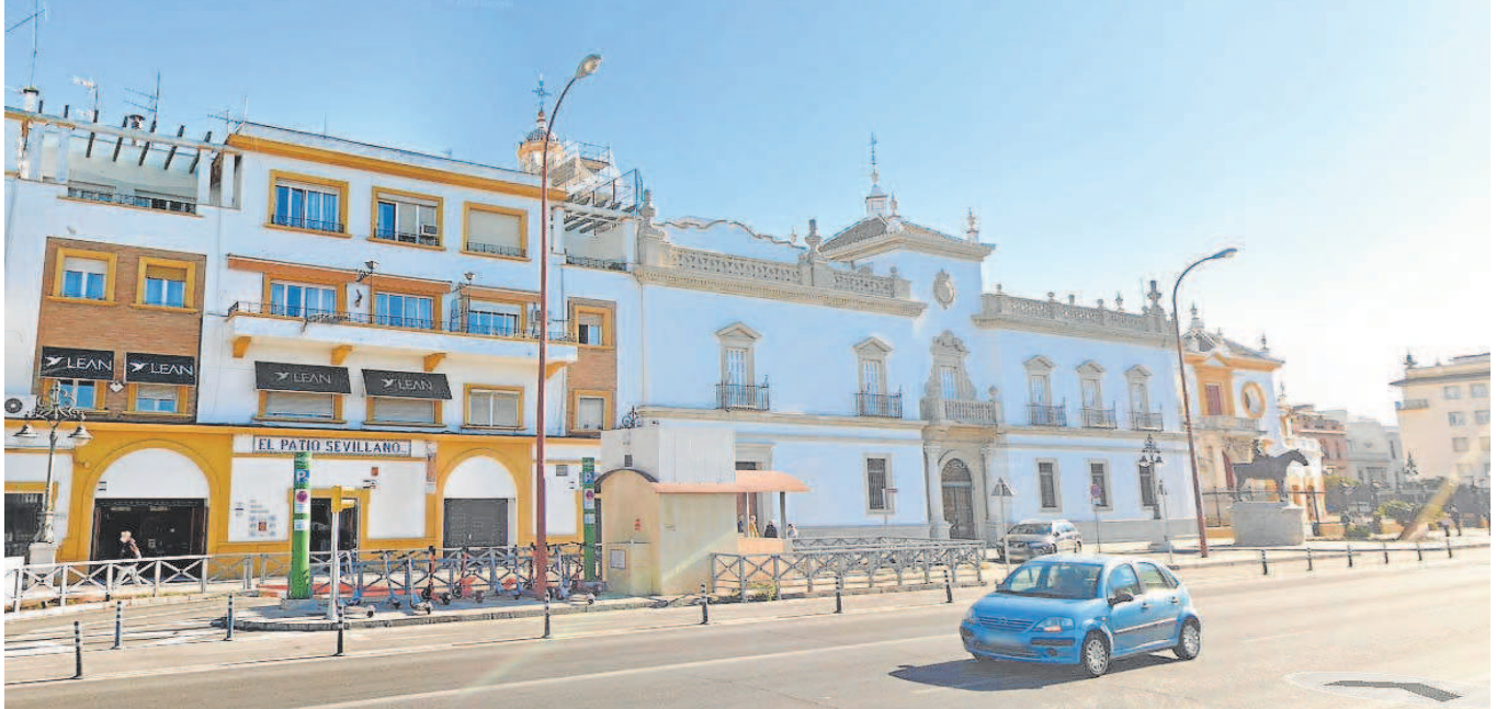
Fachada del edificio que se quiere derribar para construir el proyecto de 36 apartamentos turísticos // GOOGLE
