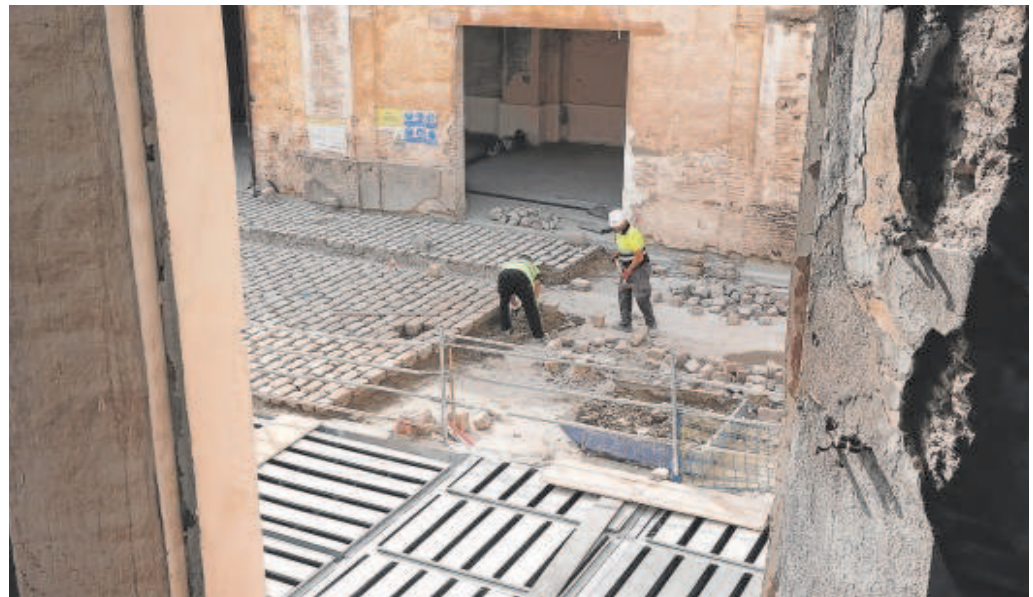
Las obras de rehabilitación de la Fábrica de Artillería acumulan años de retraso // MANUEL GÓMEZ
